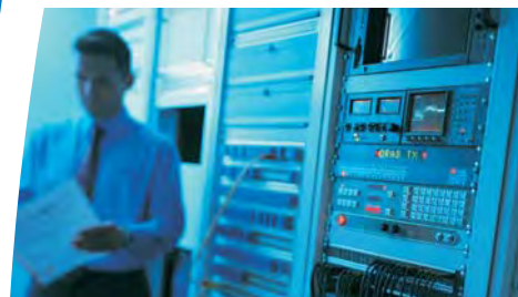
Serveurs, Stockage et équipements réseaux.
